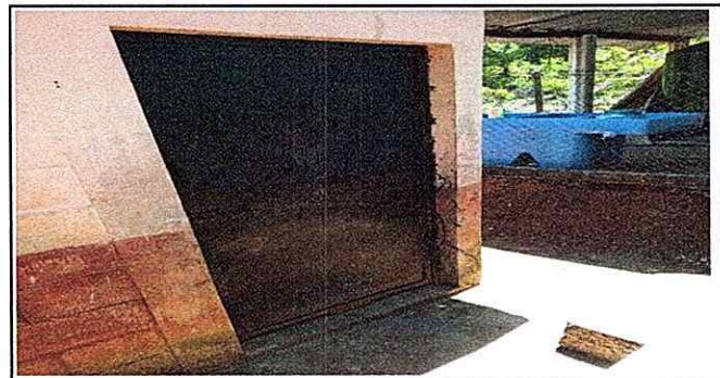
Foto 6: SUSTITUCION DE PUERTA DE LA COCINA
