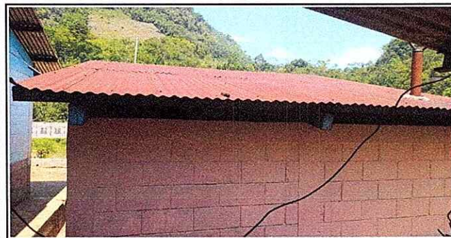
Foto 5. SUSTITUCION DE TECHO DE LA COCINA
